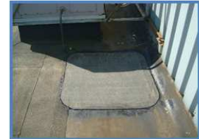
Gebreken hersteld met bitumineuze dakbedekking
