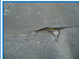
Diverse gebreken tpv naden en overlappen
